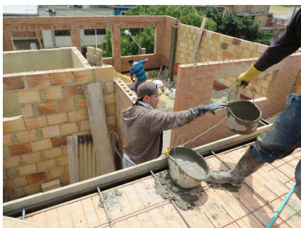
3. Stock im Bau (Januar 2016)
